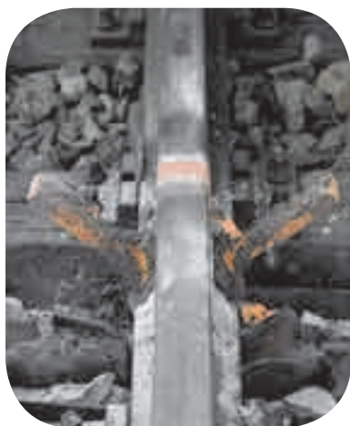
Kontrola procesu wykonania i pomiary odbiorcze parametrów geometrycznych złącza szynowego
