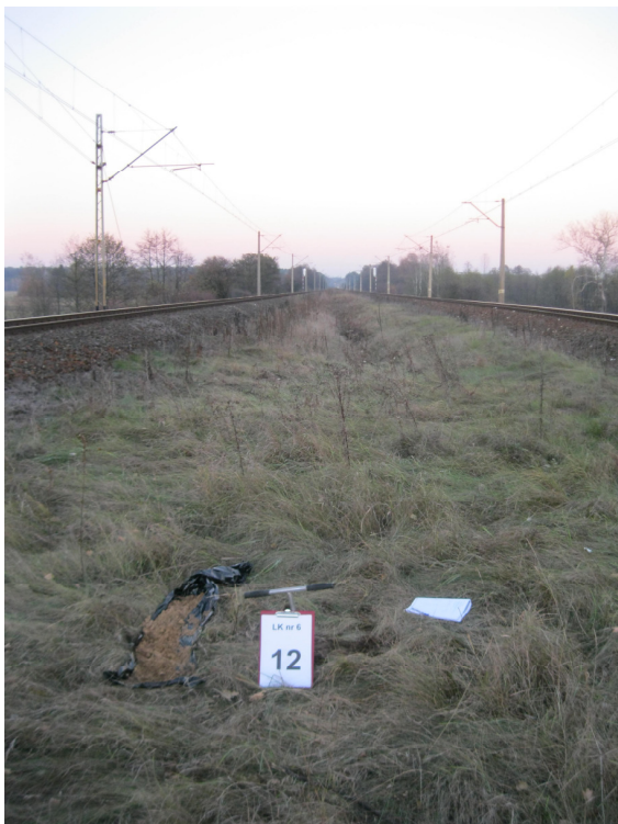
Fot. 2. Linia kolejowa nr 6, odcinek Prostyń Bug – Małkinia.
