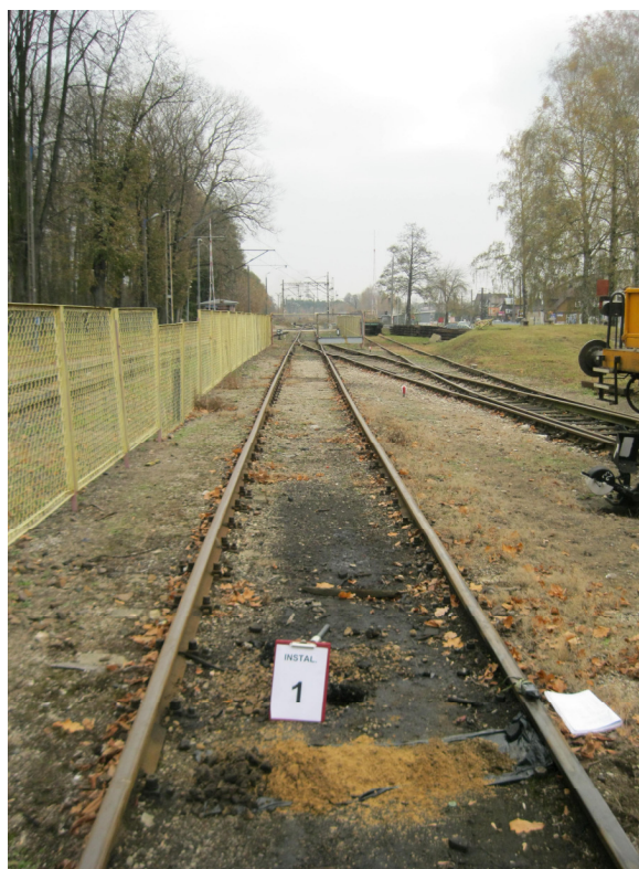
Fot. 5. Stanowisko do naprawy sprzętu kolejowego na stacji kolejowej w Małkini.
