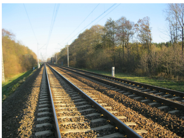
Fot. 1. Linia kolejowa nr 2, odcinek Mińsk Mazowiecki – Siedlce.
