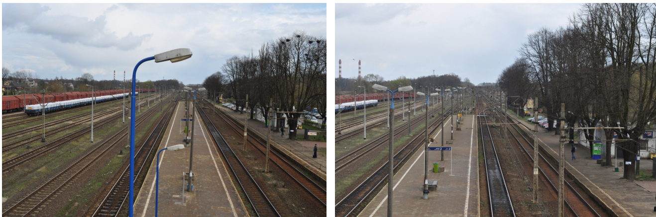
Fot. 4. Stacja kolejowa Małkinia (źródło: archiwum PKP PLK S.A.)
